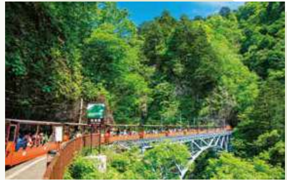
黒薙駅・後曳橋 注:後曳橋は徒歩では渡れません。
