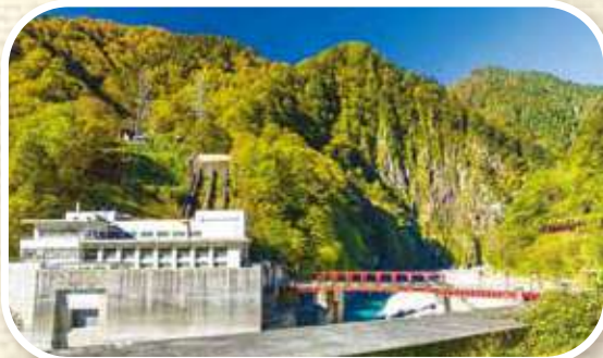
黒部川第二発電所・目黒橋 ねずみ返しの岩壁
