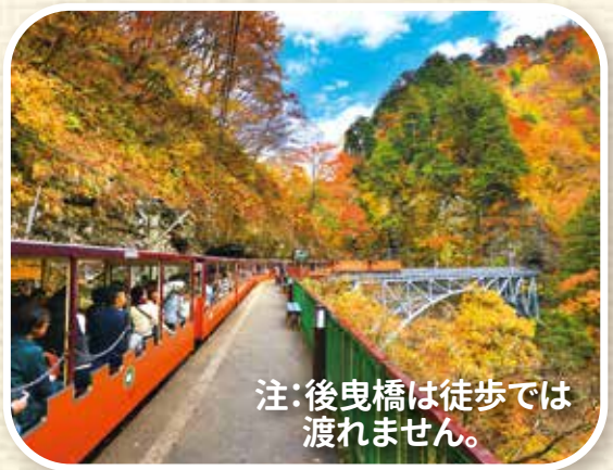
黒薙駅・後曳橋
